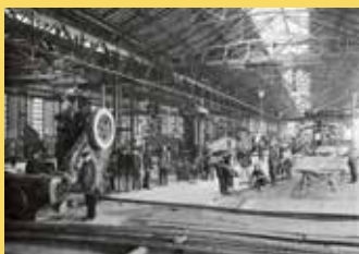
Trabajo en el interior de las instalaciones de astilleros en 1930. Al pie: “Chapa principal cuaderna 40”.
