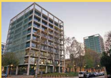
Torres de oficinas que rodean los edificios restaurados del antiguo panóptico carcelario. Foto: Alberto Gómez Roda, diciembre 2022.
