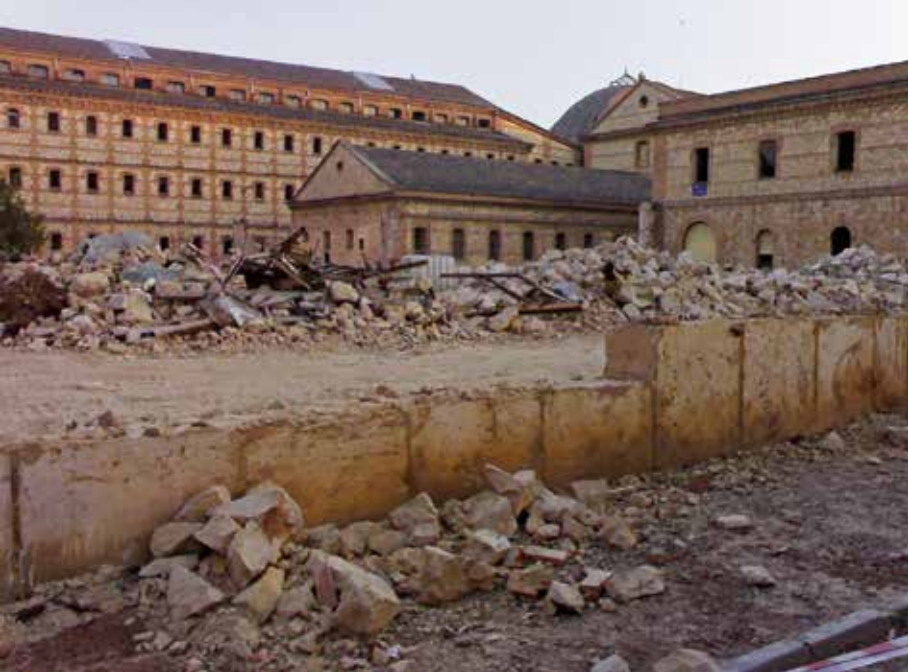
Derribo de los muros exteriores. Foto: Francisco Serrano Vidal, 2008.
